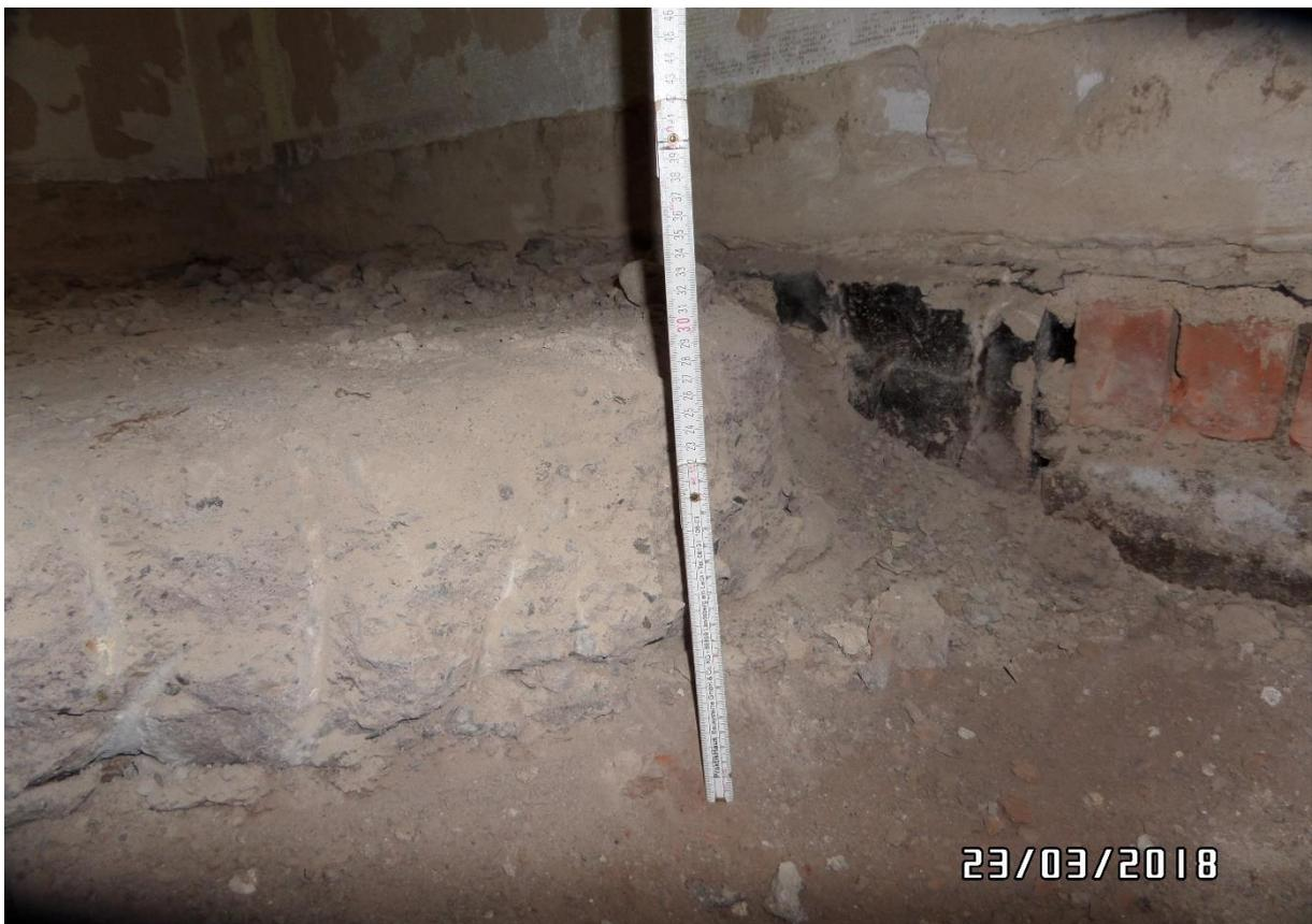
Die unvorhersehbare Dicke des Unterbetons hat zu vermehrtem Aufwand beim Ausbau geführt
