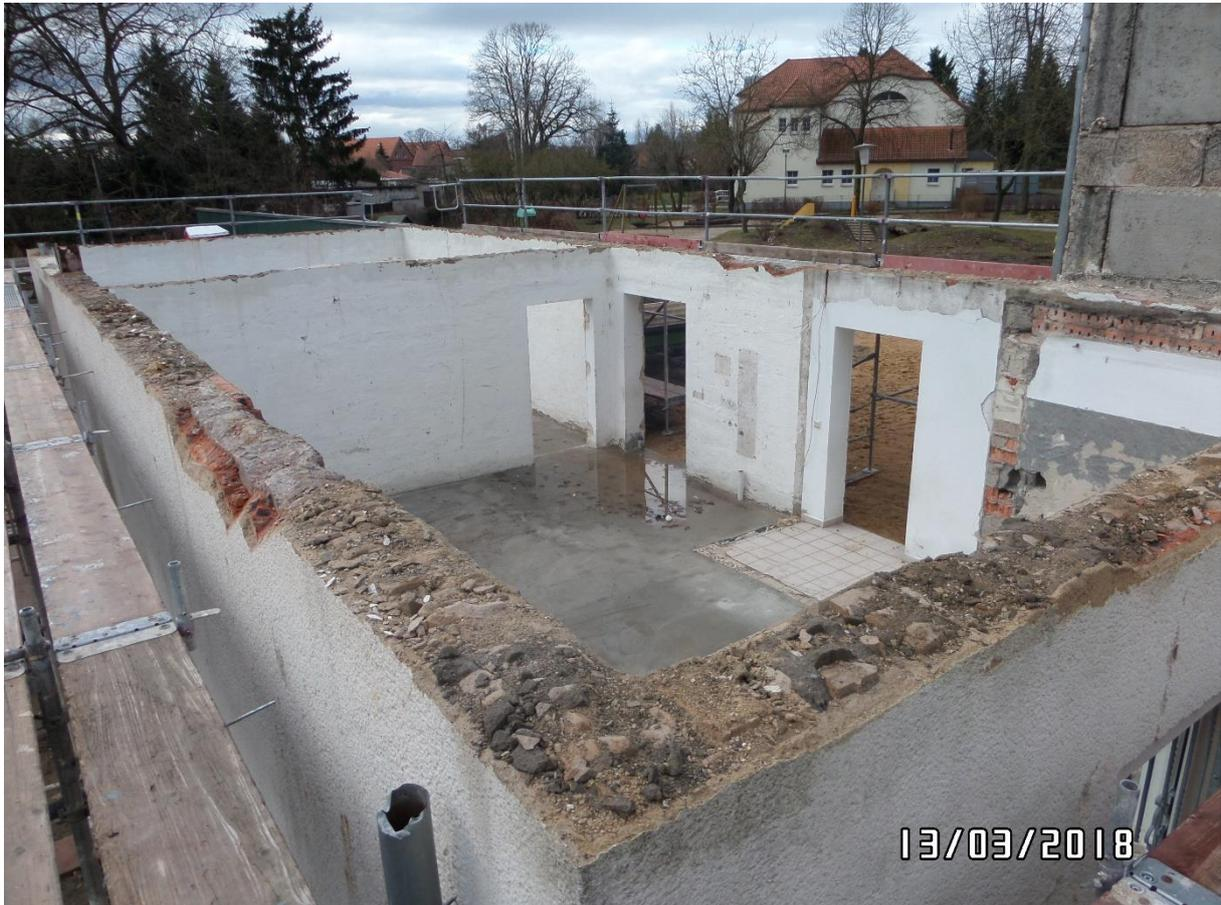
Abbruch des alten Heizhauses, diese wird nach den Umbauten zu Werkstatt und Aufenthaltsraum Hausmeister, sowie Kinderwagenabstellraum, Außenspielgeräte Lager und Außentoilette
