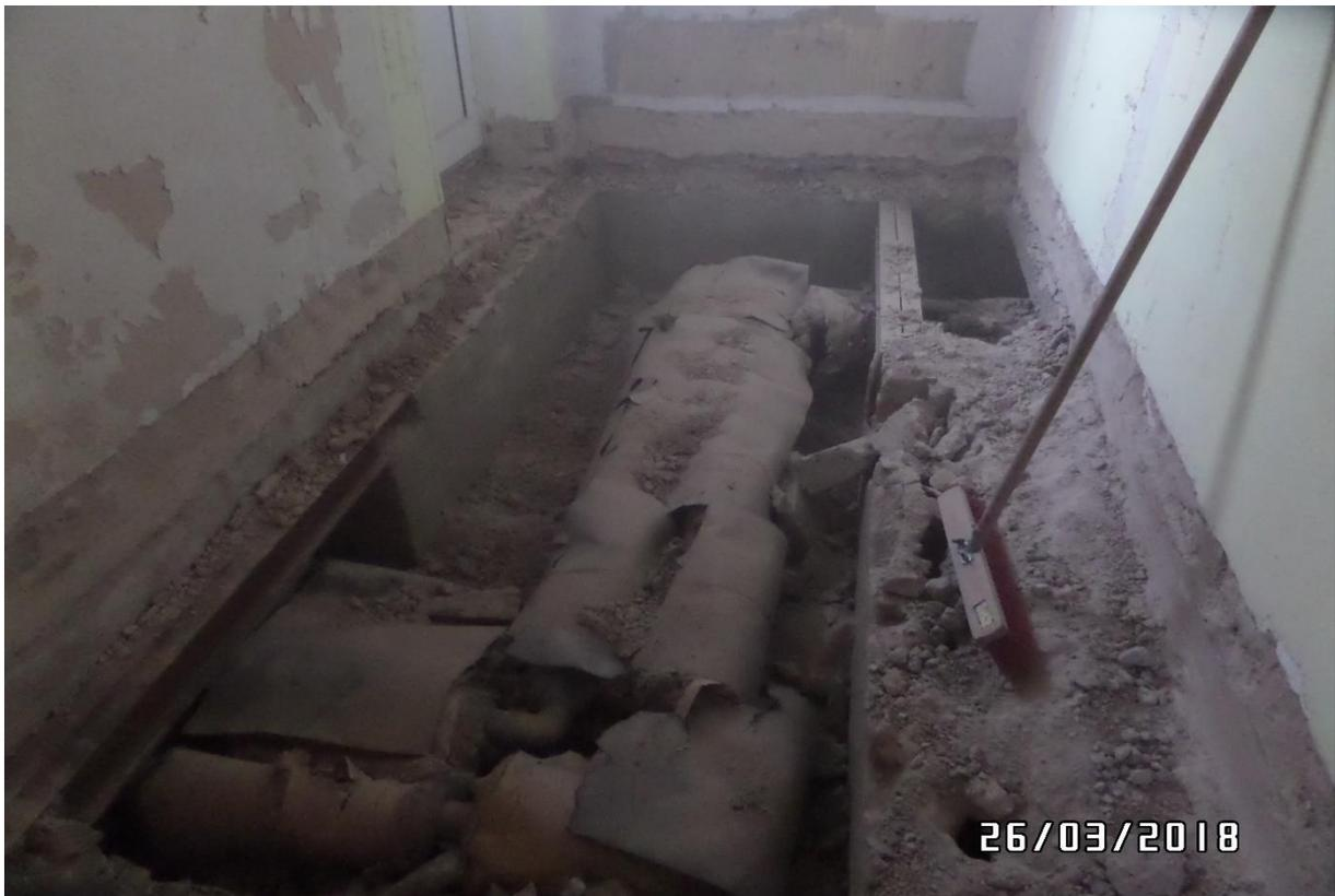
Nach den Umbauarbeiten wird die gesamte Kita über eine Fußbodenheizung beheizt. Die alten Versorgungsleitungen mussten dafür ausgebaut werden
