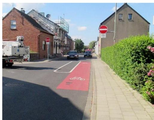
Abb. 5-32: Prinzipskizze und Beispiel (Meerbusch) zur Markierung einer Einfahrt
