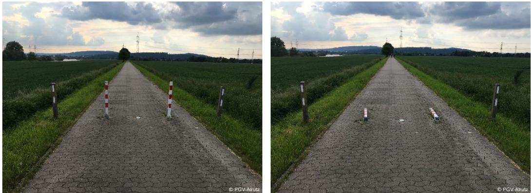
Abb. 5-34: Umklappbare Poller in hoch- und runtergeklapptem Zustand (Weserradweg, bei Hameln)
