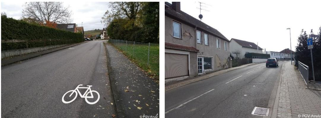
Abb. 5-28: links: Beispiel zur Markierung beidseitiger Piktogrammketten (Landkreis Lössach); rechts: Beispiel zur Anwendung in Haldensleben (Hundisburger Straße, Althaldensleben)
