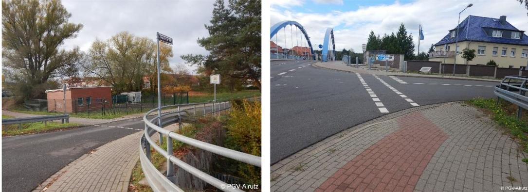
Abb. 5-30: Beispiele in Haldensleben für weit von der Fahrbahn abgesetzte Furten von Radverkehrsanlagen im Zuge von Hauptverkehrsstraßen (links: Knotenpunkt B 245/ Dönstedter Straße; rechts: Knotenpunkt Süplinger Straße/ Schützenstraße)
