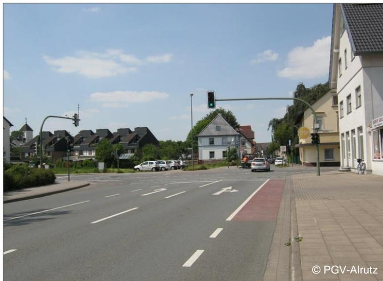
Abb. 5-18: Vorbeifahrstreifen in einer signalisierten Knotenpunktzufahrt (Bielefeld)
