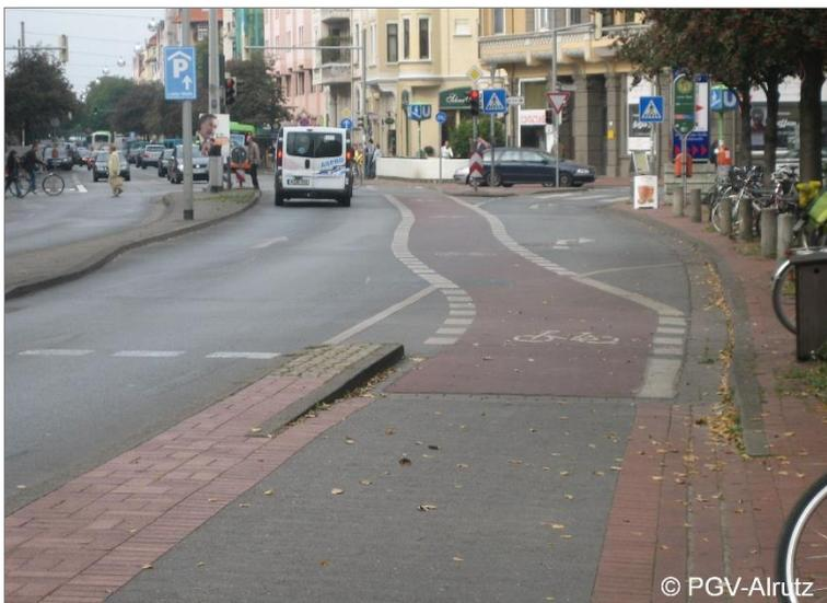
Abb. 5-17: Übergang Radweg in Radfahrstreifen an signalisiertem Knotenpunkt (Hannover)
