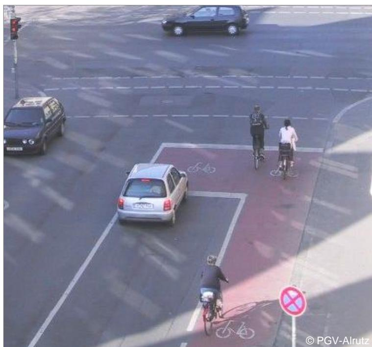
Abb. 5-20: Aufgeweiteter Radaufstellstreifen (ARAS) (Hannover)
