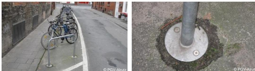
Abb. 6-3: Beispiele für verschraubte Rahmenhalter (Lüneburg)
