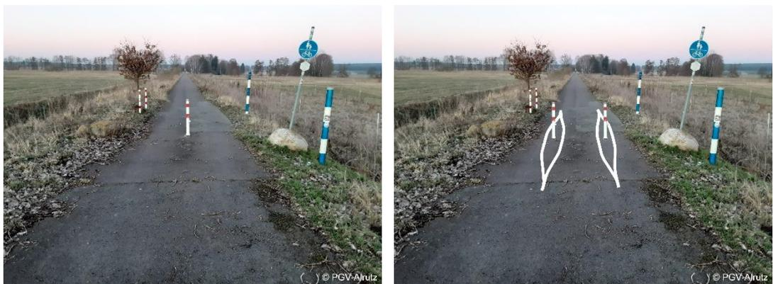
Abb. 5-35: Poller ohne Bodenmarkierung (links) und Poller mit Bodenmarkierung (rechts, Fotomontage) in Haldensleben
